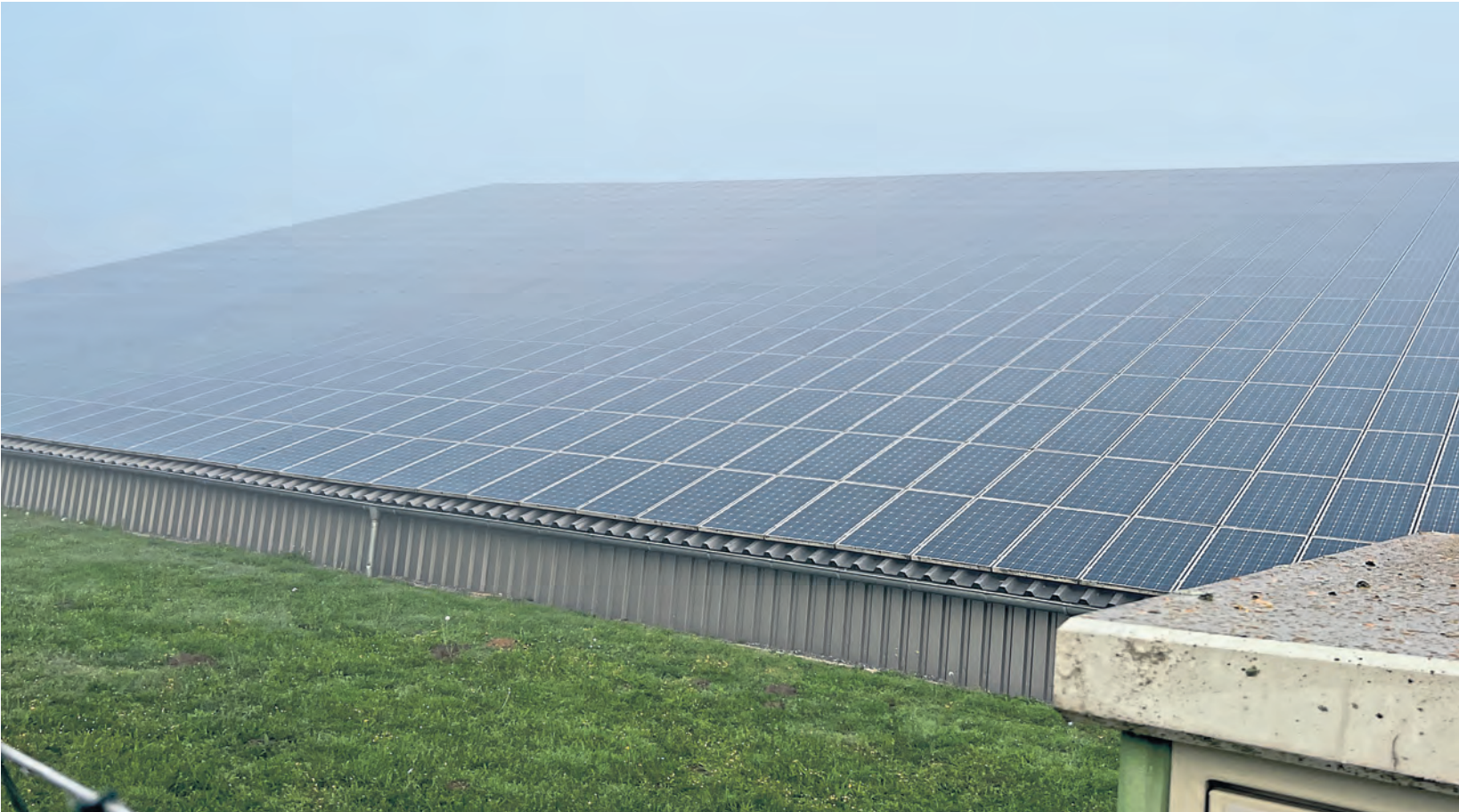
Die Anzahl an Photovoltaik-Anlagen im Flecken Steyerberg, wie hier an der Straße Auf dem Acker, wird zunehmen.
